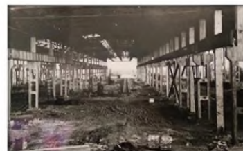
Строительство литейного цеха, 1976 г.
